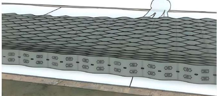
Despliegue e instale la GEOCELDA.
