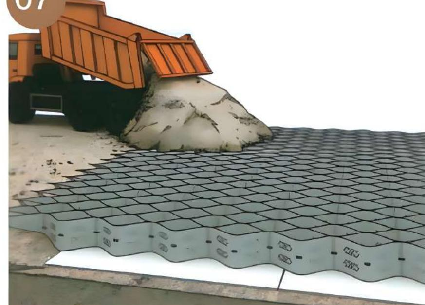
Rellene la GEOCELDA con el material de relleno.
