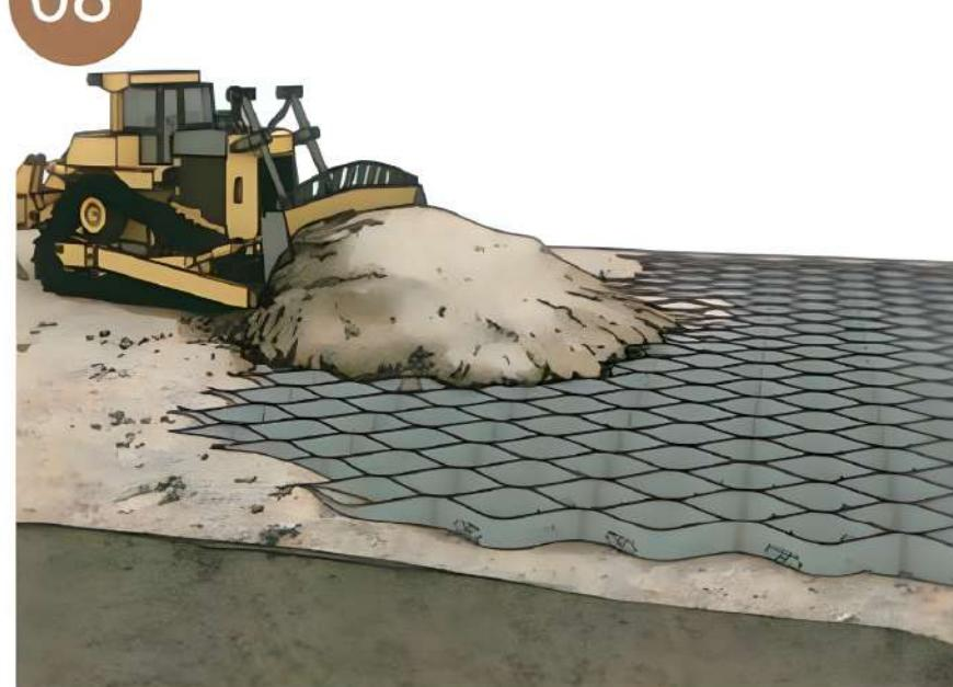
Distribuya la tierra y el relleno de manera uniforme utilizando el equipo adecuado.
