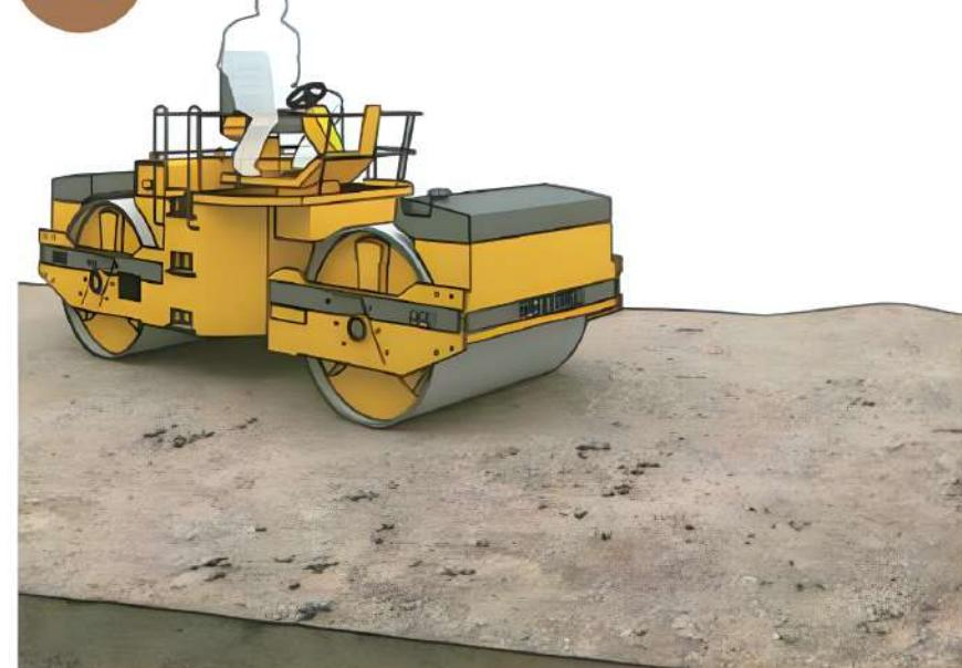
Compacte el terreno utilizando un rodillo o compactador.
