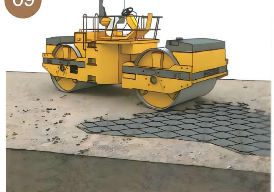
Compacte la GEOCELDA rellena con un rodillo o compactador.
